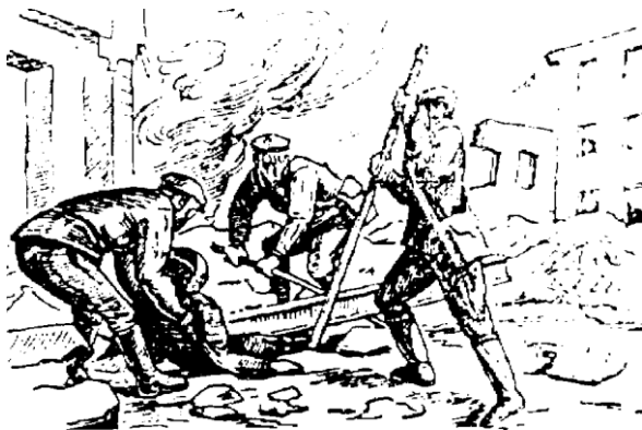
Рис. 3. Разборка завала вручную
