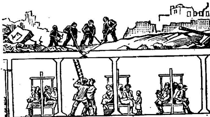
Рис.17 - Пробивание отверстия в перекрытии убежища
