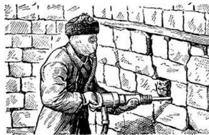
Рис. 15 - Пробивание отверстия в стене убежища для подачи очищенного воздуха от вредных веществ
