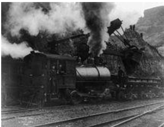
Рисунок 11. Работает паровой экскаватор
