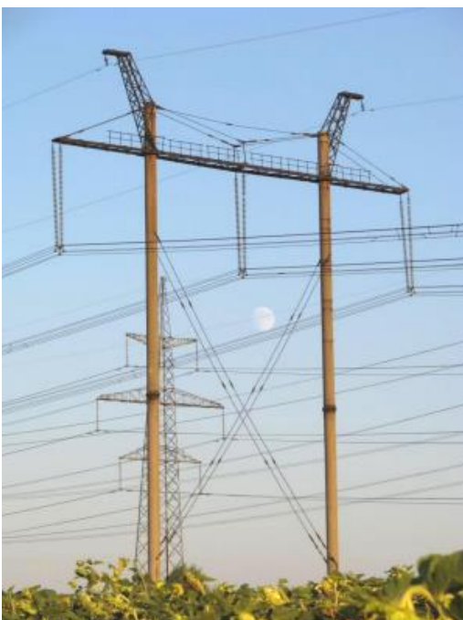
Рисунок 14- Общий вид и конструктивные особенности опор на базе секционированных железобетонных стоек
