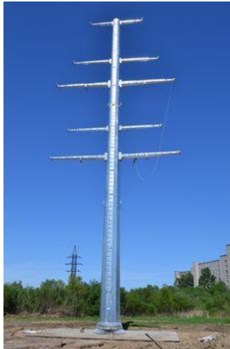
Рисунок 12- Общий вид и конструктивные особенности опор типа ММО
