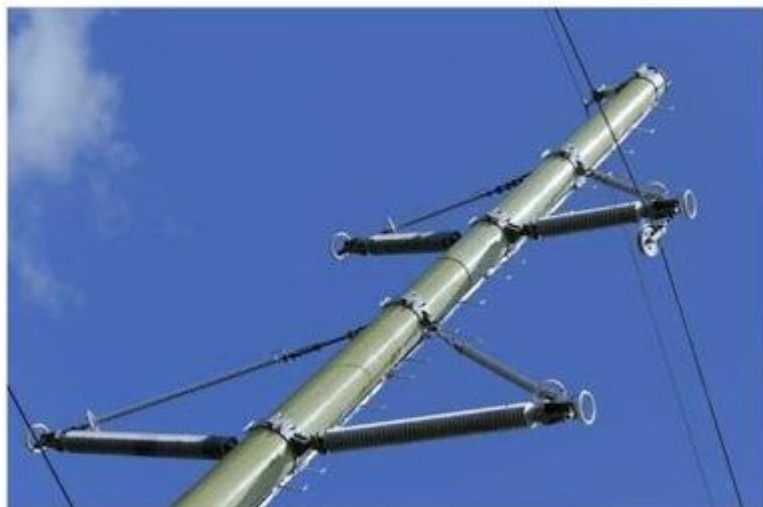
Общий вид композитной опоры
