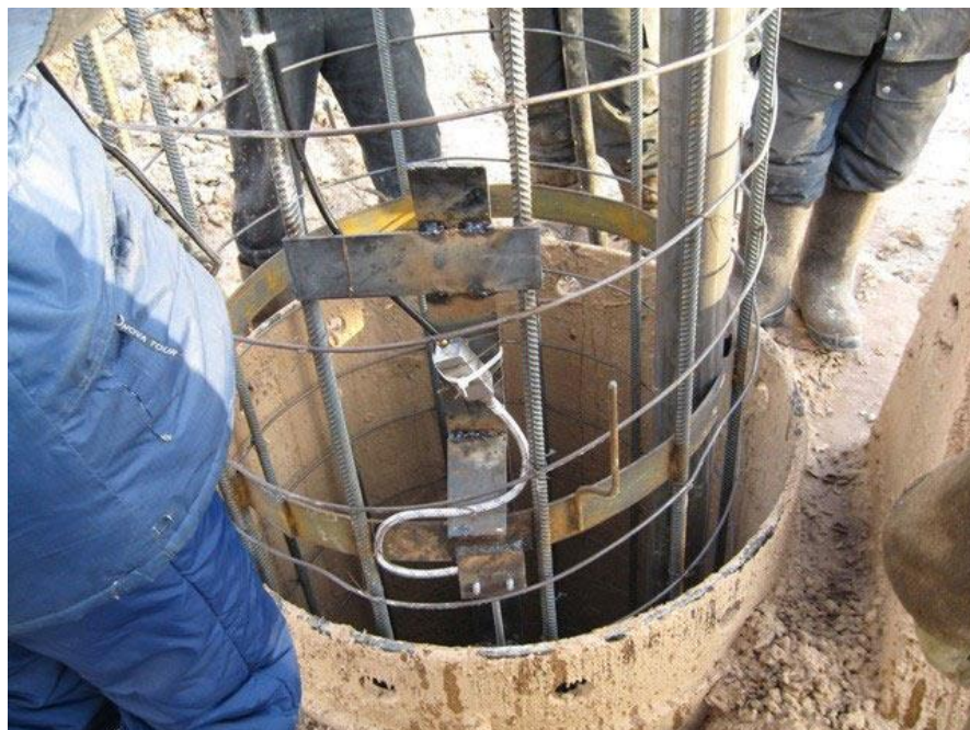
Рисунок 9- Общий вид арматурного каркаса в обсадной трубе до бетонирования.
